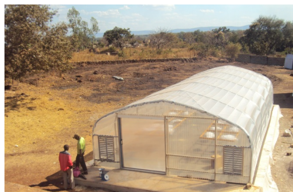
Séchoir serre solaire CSec-S sur dalle bétonnée (© A. Diallo, ESP)
